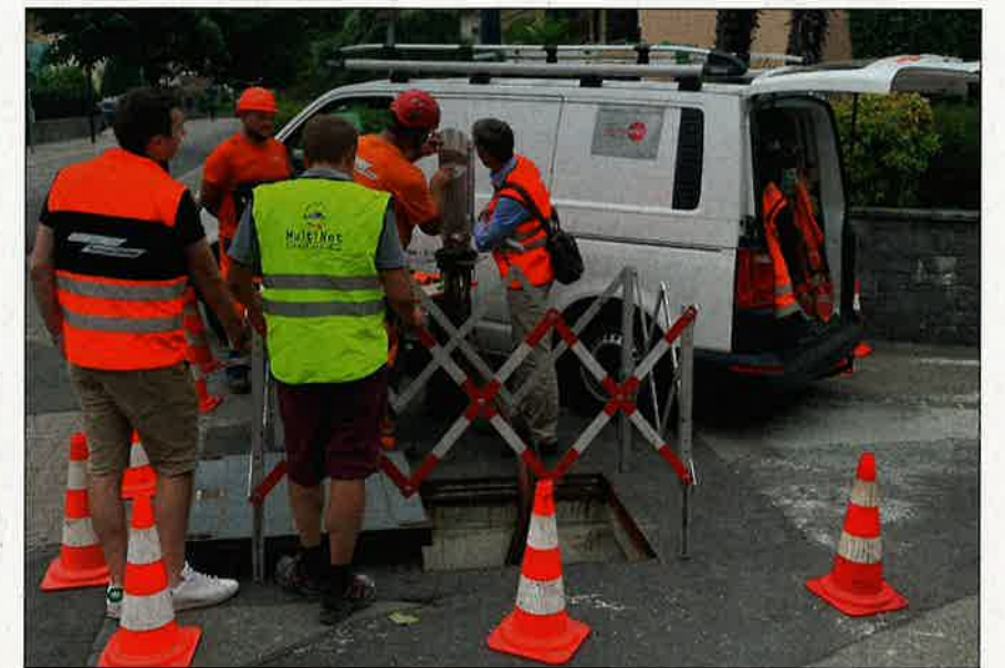
Swiss4net baut offene Glasfasernetze in bestehenden Rohre der EVU und Gemeinden – und das bis hin zu den Glasfasersteckdosen in den Wohnungen und Unternehmen.
